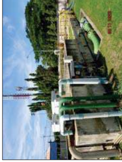
รูปที่ 7 บ่อพักน้ำทิ้งสุดท้าย (Final check basin)
