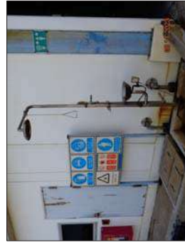
รูปที่ 17 อ่างล้างตา และฝักบัวล้างตัว ในพื้นที่โครงการ
